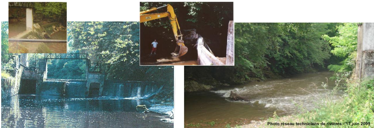
Exemple d'effacement d'un ouvrage de 1.7m de haut sans conséquences en amont, Rhins à Régný. CCPAT Note : le seuil était responsable d'une inondation de l'industrie voisine de 45cm en crue de retour 50 ans.
